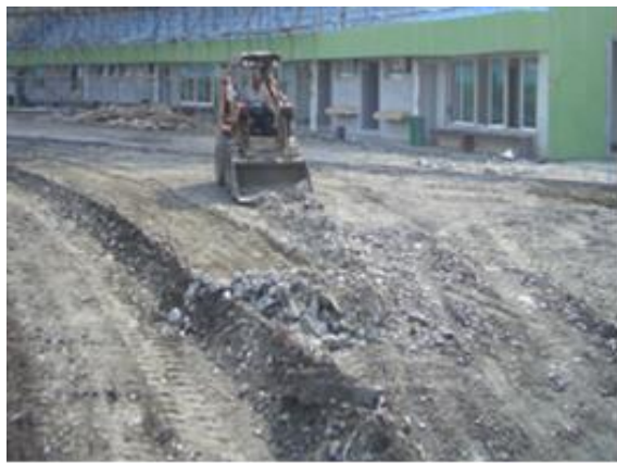
鋪設碎石級配層
