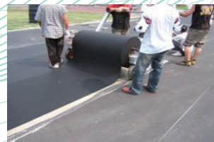
底層橡膠墊展開鋪設
