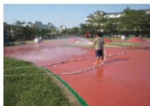
護平層完工後試積水
