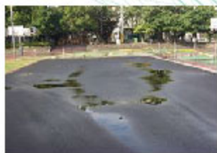
基礎層檢視 (積水測試檢查洩水坡度)
