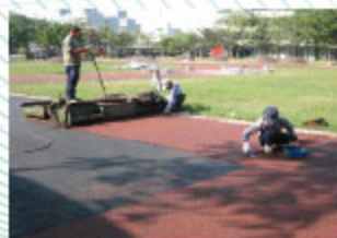
跑道顆粒基層鋪設
