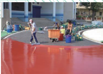
1. 彈性基層施作
