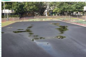
基礎層檢視 (積水測試檢查洩坡度)
