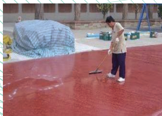
2. 積水測試及補積水
